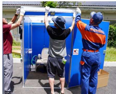
マンホールトイレ設置の様子
