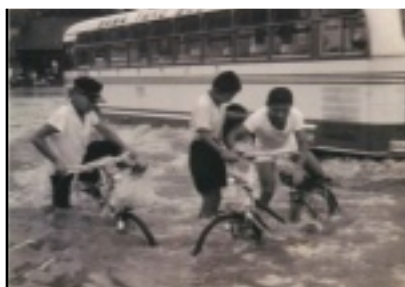
昭和39年(1964)年7月朝 山陰集中豪雨による上井駅前 冠水 ※転載「昭和の上井」から
