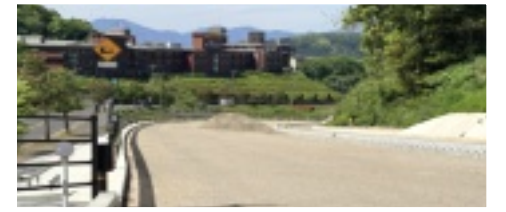
(上) 拡幅工事が進む ※短大から駅方向 (左) 正門前の看板
